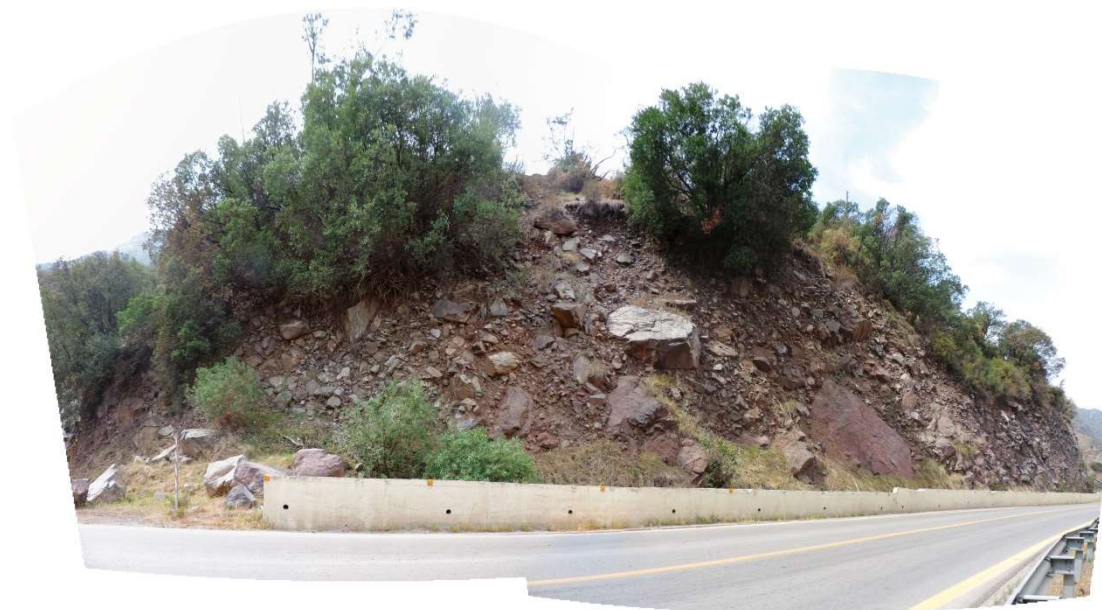
Figura N° 8.3—8: Vista en corte de los depósitos antiguos de remociones en masa en el kilómetro 10 del Camino a Farellones
